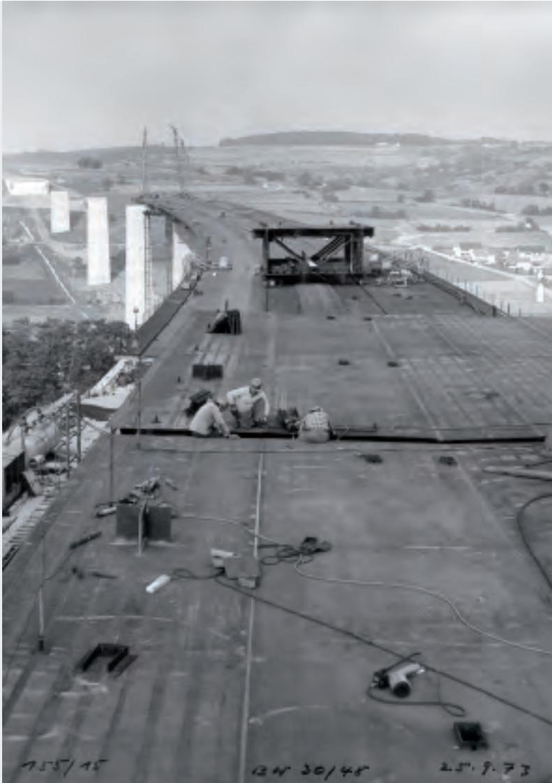
Jagsttalbrücke Widdern in km 512,700, Einpassen eines Hohlkastenschlusses, rechts im Bild Widdern / 25.09.1973
