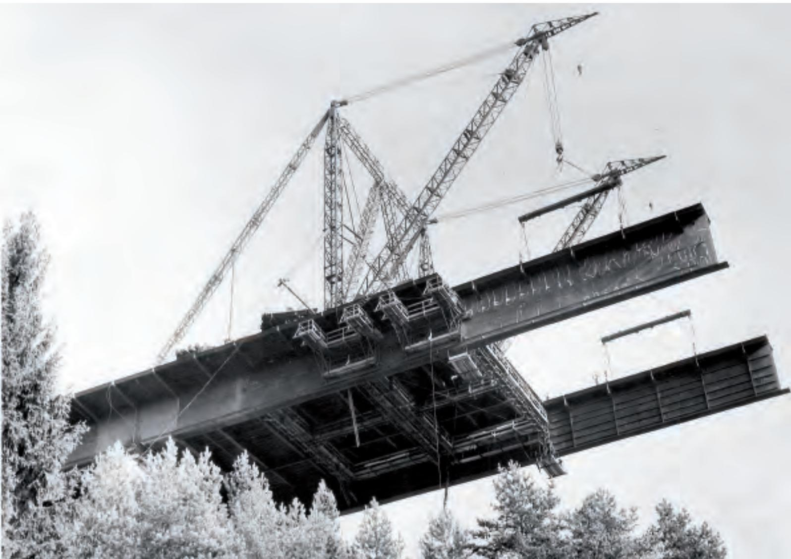
*Talbrücke Rötenstein, km 468,726 – 469,094, Stahlüberbau im Freivorbau / 13.10.1969 (Repro: 11.09.1992)
