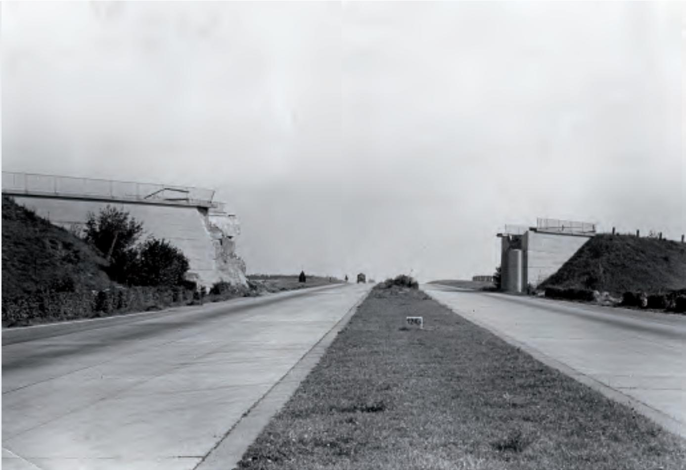
*Überführung der B 10 Ulm – Stuttgart in km 123,950; die Brücke wurde im April 1945 gesprengt, 1949 als Spannbetonbrücke mit Fertigteilträgern wiederaufgebaut und dann 1976 anlässlich des*
