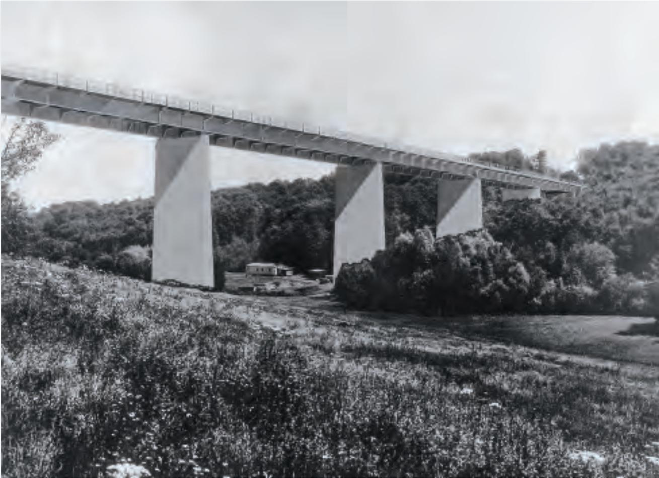
*Sulzbachviadukt in km 186,136, Photomontage L = 365 m; die Brücke wurde als Stahlkonstruktion 1934 - 36 gebaut, am 18.04.1945 gesprengt, 1952–54 wiederaufgebaut, am 15.12.1981*
