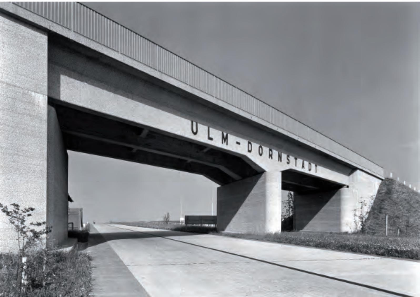
*Überführung der B 10 Ulm – Stuttgart in km 123,950; die Brücke wurde im April 1945 gesprengt, 1949 als Spannbetonbrücke mit Fertigteilträgern wiederaufgebaut und dann 1976 anlässlich des*
