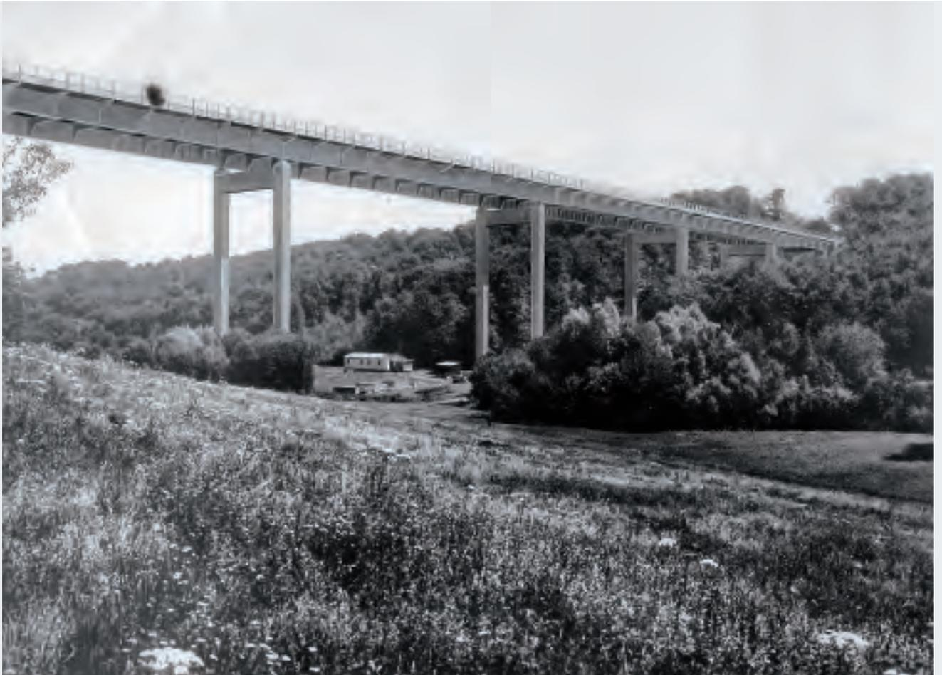
*Sulzbachviadukt in km 186,136, Photomontage L = 365 m; die Brücke wurde als Stahlkonstruktion 1934 - 36 gebaut, am 18.04.1945 gesprengt, 1952-54 wiederaufgebaut, am 15.12.1981*
