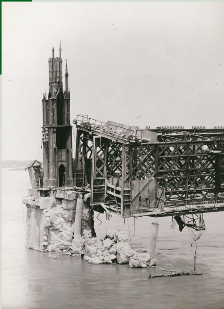
Zerstörter Strompfeiler der Kehler Rheinbrücke, 1940. GLA Karlsruhe 421 Zugang 2000-7 F Nr. 1
