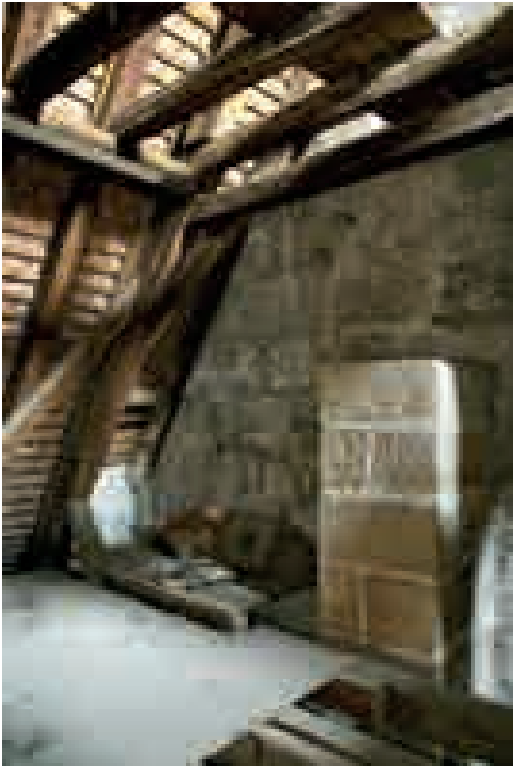
11 | Dachwerk des Sakristeibaus: Blick nach Südost auf den Anschluss des Dachwerks an die Chornordwand
