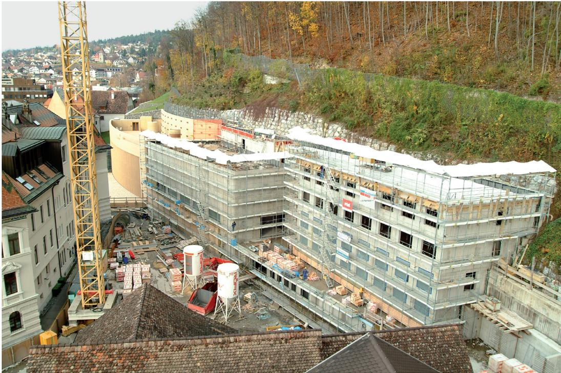
Nach Abschluss der Betonarbeiten konnte mit der vorgemauerten zweiten Schale begonnen werden, Stand Mitte November 2008.
