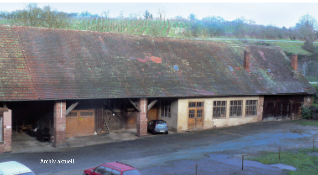
Das sogenannte Schreinereiwerkstattgebäude im oberen Wirtschaftshof des Klosters Bronnbach. Im hinteren Drittel wird das neue Magazin errichtet. Aufnahme: Landesarchiv
