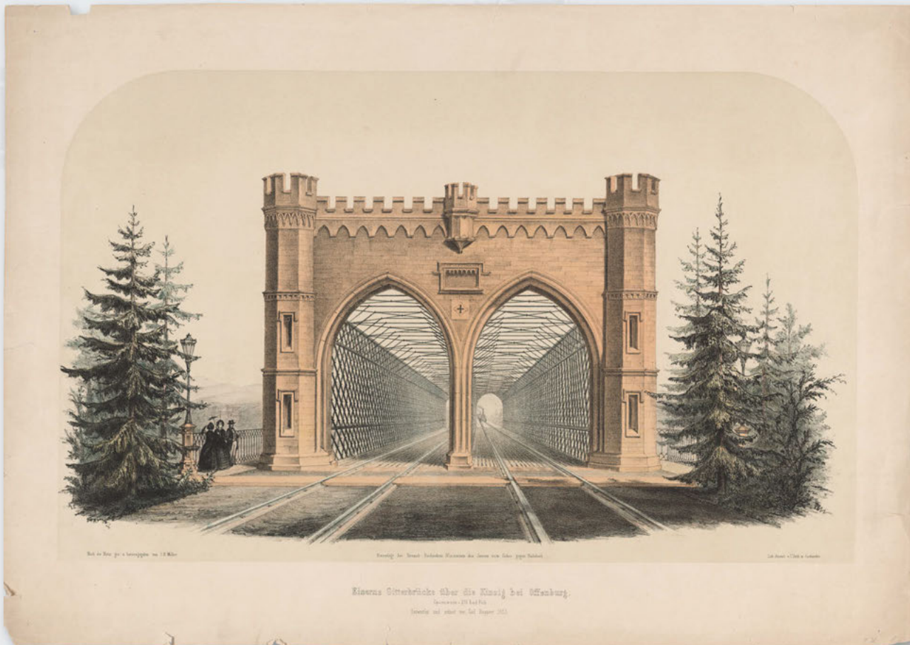
Eisenbahnbrücke über die Kinzig bei Offenburg, ca. 1853. GLA Karlsruhe J-B Offenburg 6
