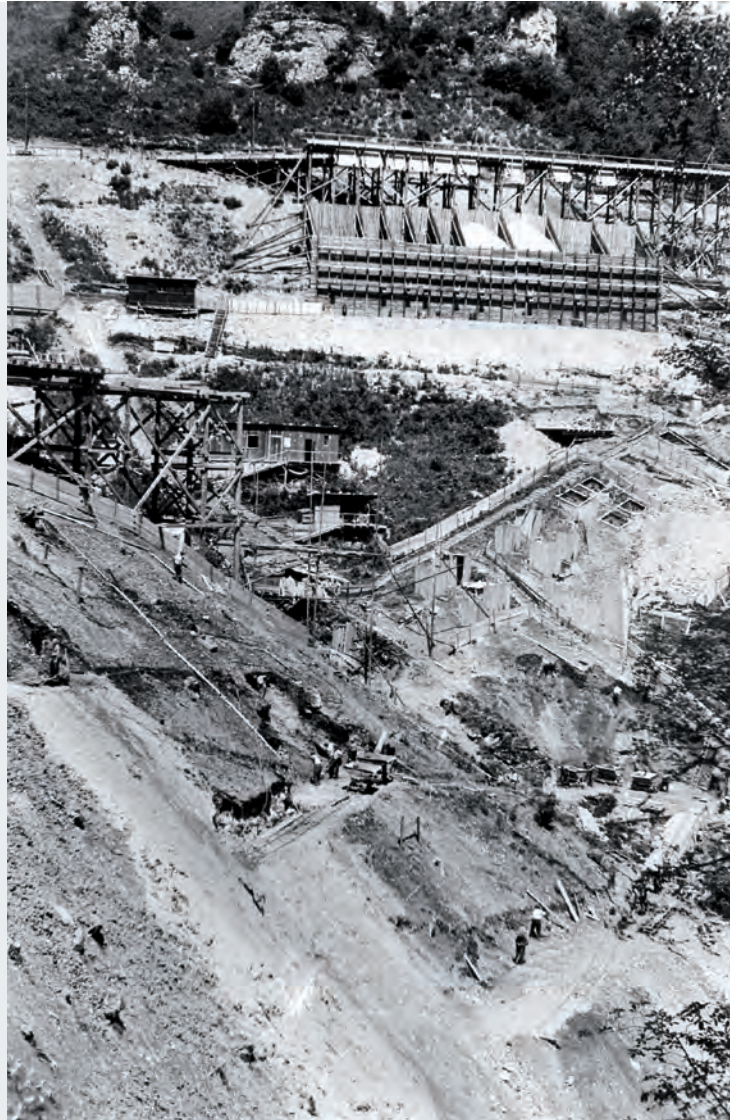
Drachenlochbrücke, km 152,933, Baustelleneinrichtung; die Brücke wurde 1935–1937 gebaut, 1945 gesprengt und 1949/50 wieder aufgebaut. / 1935 (Repro: 04.05.1993) Landesarchiv Baden-Württemberg StAL EL 75 VI a Nr 3098
