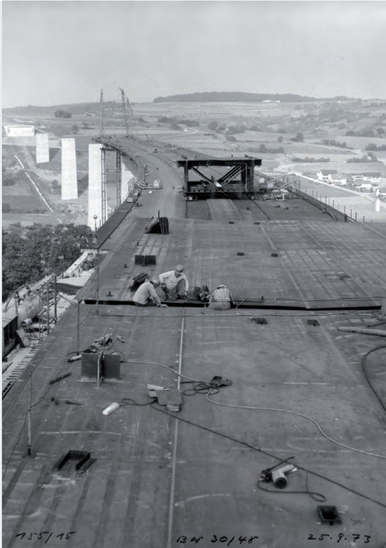
Jagsttalbrücke Widdern in km 512,700, Einpassen eines Hohlkastenschlusses, rechts im Bild Widdern / 25.09.1973 (Repro: 11.09.1992) Landesarchiv Baden-Württemberg StAL EL 75 VI a Nr 5651
