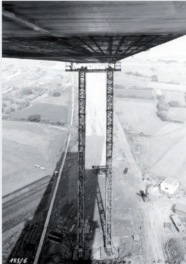
Jagsttalbrücke Widdern in km 512,700, Blick von Pfeilerkopf E auf Hilfsstütze H 101 / 25.09.1973 (Repro: 11.09.1992) Landesarchiv Baden-Württemberg StAL EL 75 VI a Nr 5642
