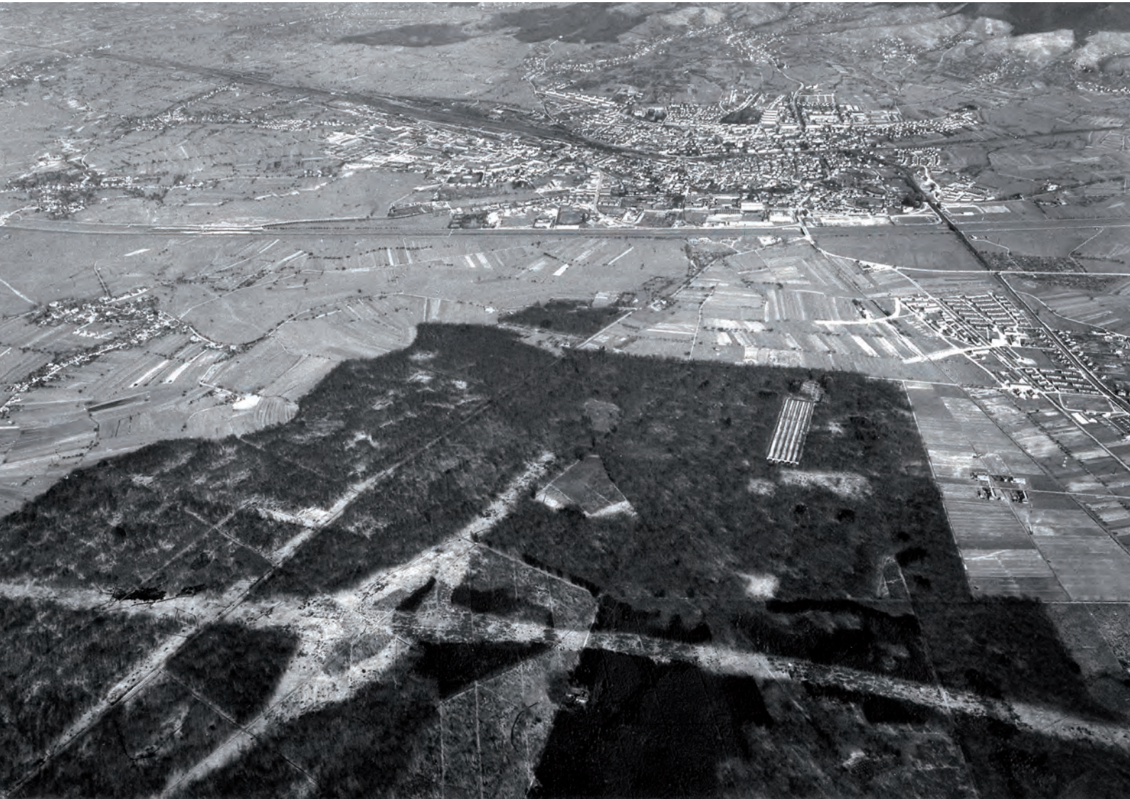
Trassierung; Stadium: Ausholzen und Freimachen der Trasse; man erkennt bereits das Offenburger Ei, im Hintergrund Offen- burg. / April 1959 (Aufnahme: Alb. Brugger, Repro: 03.02.1992) Landesarchiv Baden-Württemberg StAL EL 75 VI a Nr 1161
