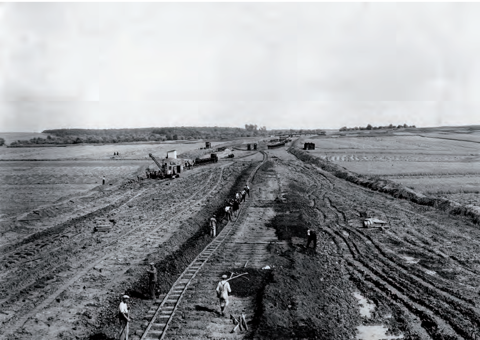
Erdarbeiten bei km 183,5 [AS Wendlingen – Sulzbachviadukt] / 1934 (Repro: 21.06.1993) Landesarchiv Baden-Württemberg StAL EL 75 VI a Nr 4366
