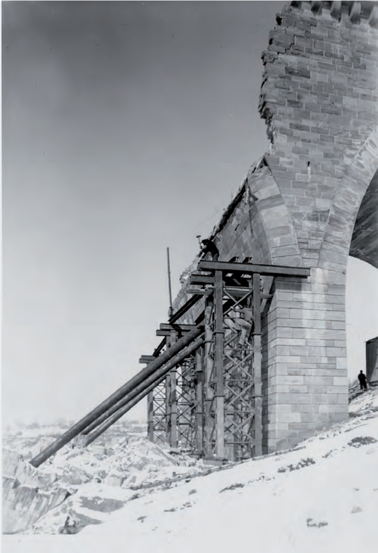
Kämpfelbachviadukt, km 246,146 – 246,504, Wiederaufbau, Sicherung, Seite Stuttgart / 1947 (Repro: 25.01.1994) Landesarchiv Baden-Württemberg StAL EL 75 VI a Nr 5390
