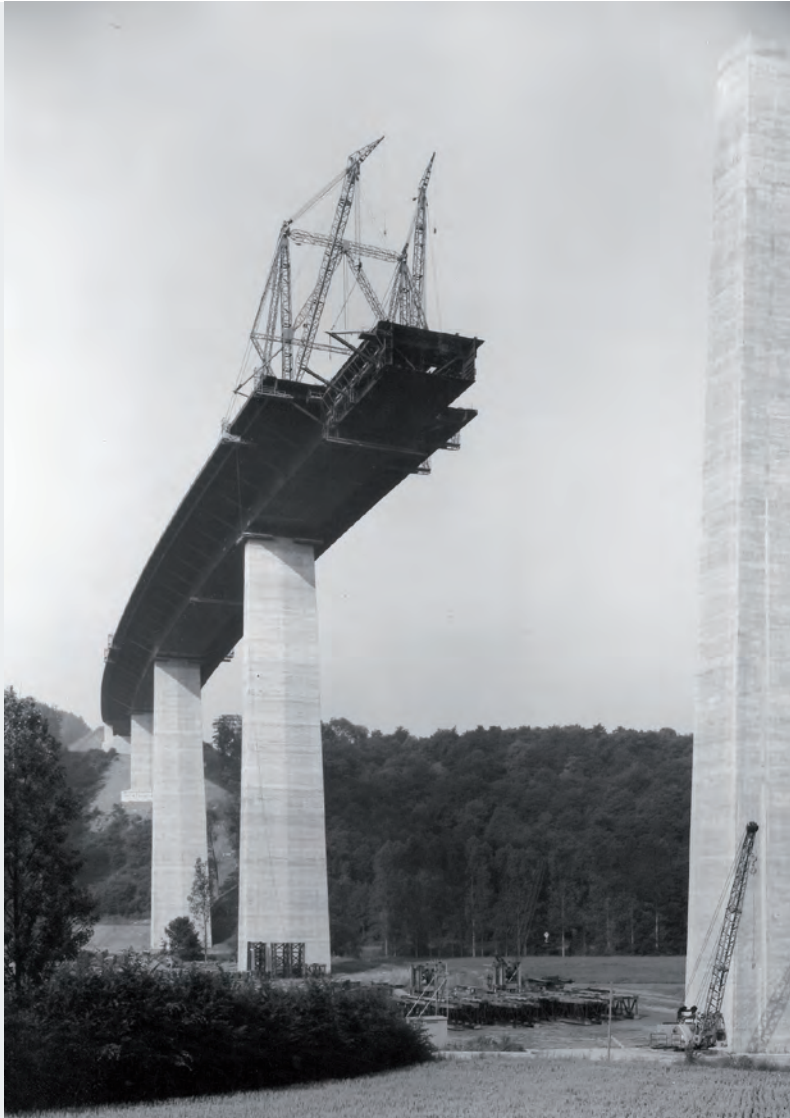
Jagsttalbrücke Widdern in km 512,700; Freivorbau im Feld D–E / 26.06.1973 (Repro: 09.09.1992) Landesarchiv Baden-Württemberg StAL EL 75 VI a Nr 5640
