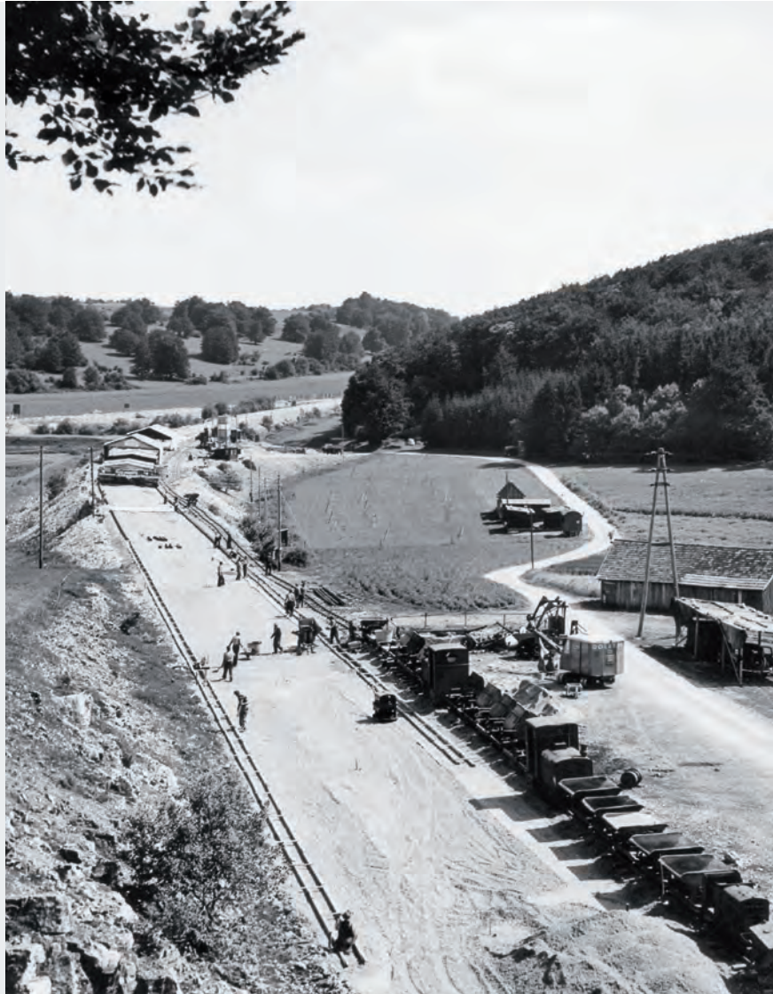
Betonieren der Fahrbahndecke [AS Hohenstadt (Albaufstieg) – Malakoffbrücke] / 1956 (Repro: 17.04.1996) Landesarchiv Baden-Württemberg StAL EL 75 VI a Nr 3263
