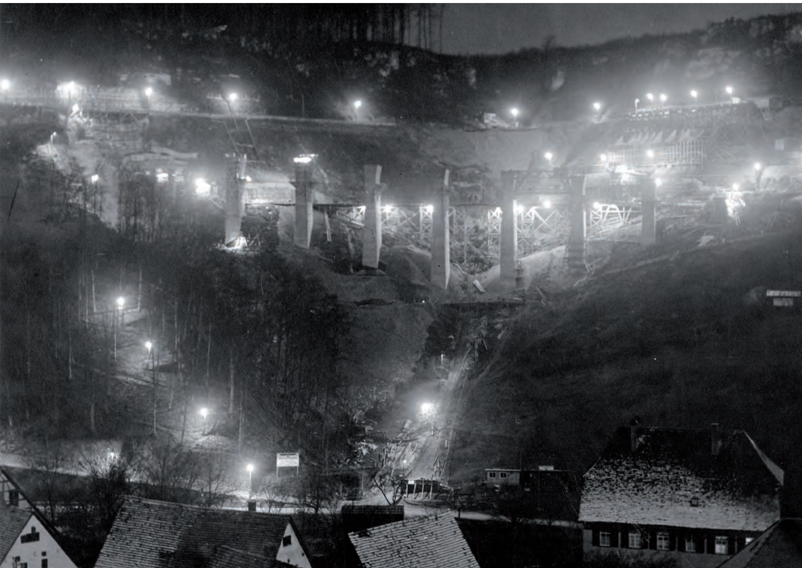
Drachenlochbrücke, km 152,933, Nachtarbeit; die Brücke wurde 1935–1937 gebaut, 1945 gesprengt und 1949/50 wieder aufgebaut. / 1937 (Repro: 04.05.1993) Landesarchiv Baden-Württemberg StAL EL 75 VI a Nr 3109
