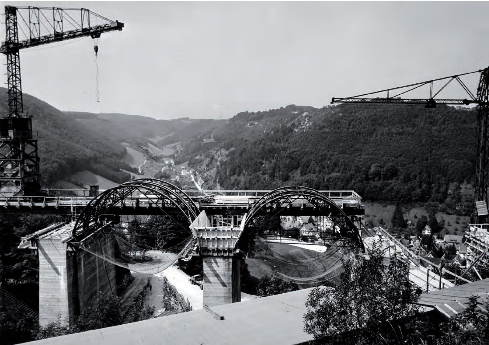
Malakoffbrücke, km 152,323 – km 152,436, Einsetzen der Lehrgerüstbögen / 1955 (Repro: 17.04.1996) Landesarchiv Baden-Württemberg StAL EL 75 VI a Nr 3367
