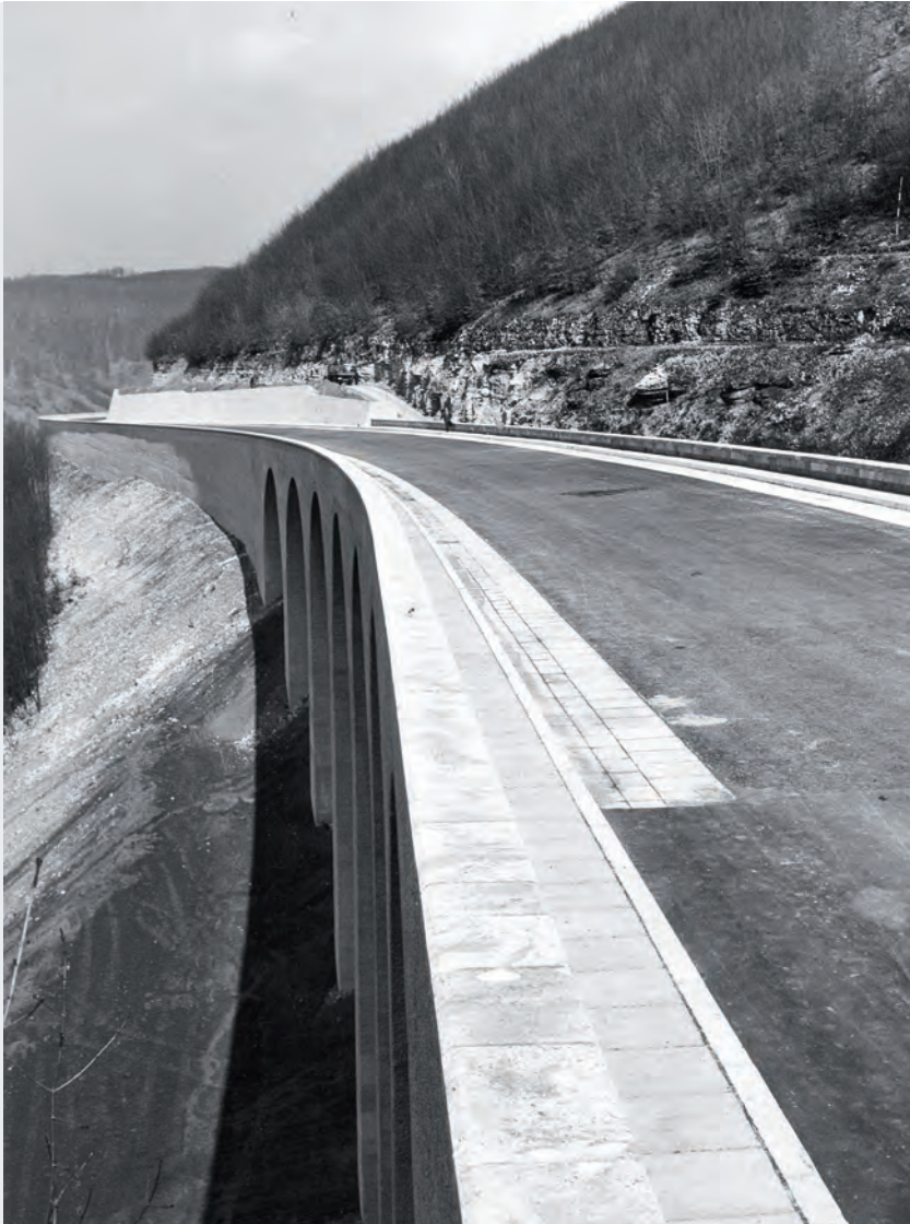
Malakoffbrücke, km 152,323 – km 152,436, Asphaltbetondecke, Brüstungsmauerwerk, Entwässerung / 1957 (Repro: 17.04.1996) Landesarchiv Baden-Württemberg StAL EL 75 VI a Nr 3378
