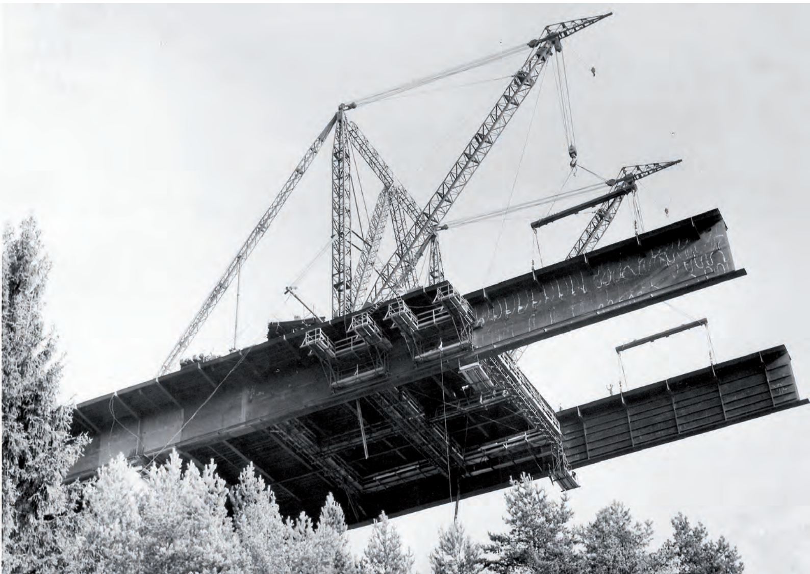
Talbrücke Rötstein, km 468,726 – 469,094, Stahlüberbau im Freivorbau / 13.10.1969 (Repro: 11.09.1992) Landesarchiv Baden-Württemberg StAL EL 75 VI a Nr 5572
