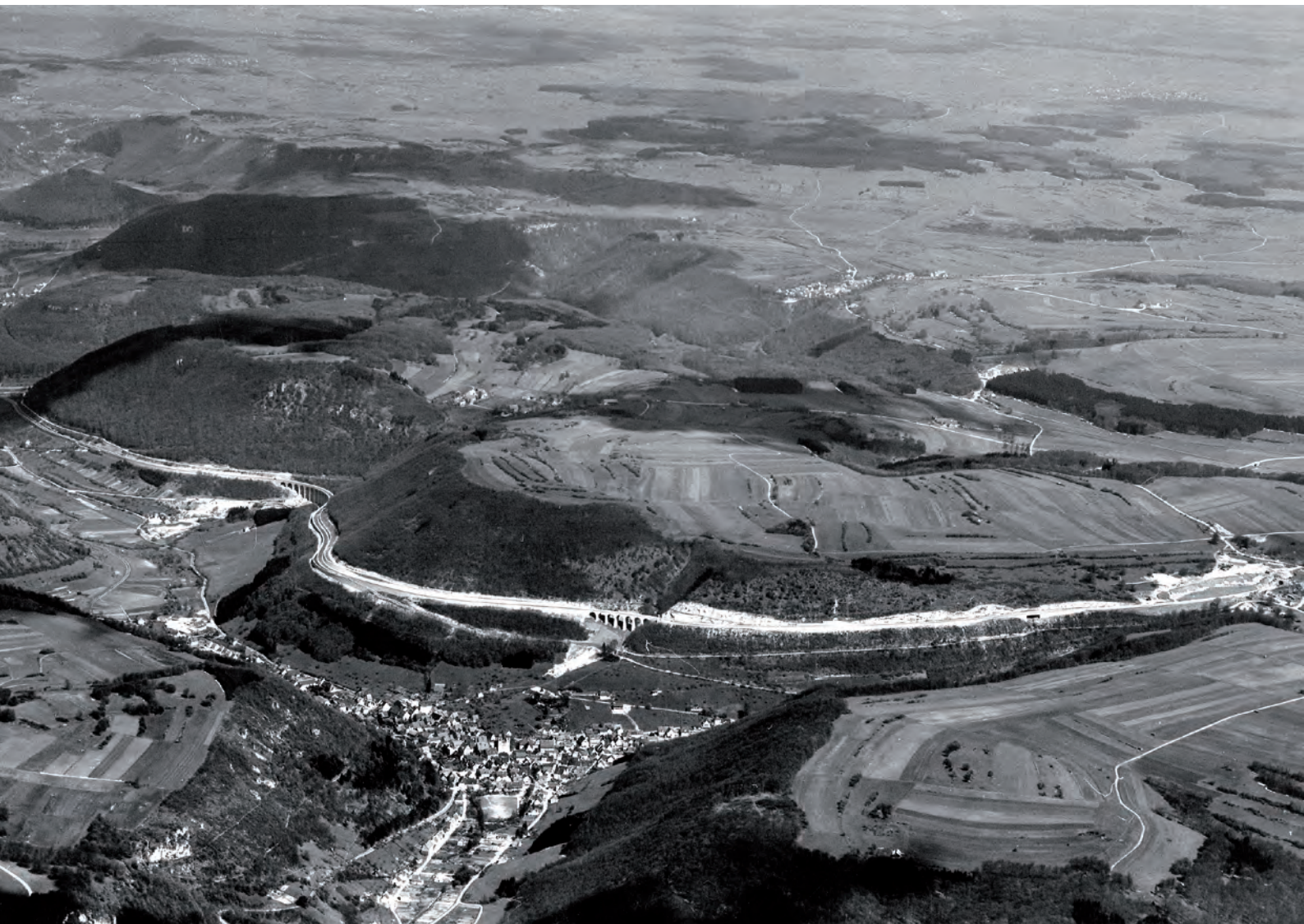
Trassierung. Links Todsburgbrücke, Mitte Malakoffbrücke, rechts Lämmerbuckeltunnel, im Vordergrund Wiesensteig / 1957 (Aufnahme: Alb. Brugger, Repro: 04.04.1996) Landesarchiv Baden-Württemberg StAL EL 75 VI a Nr 3382
