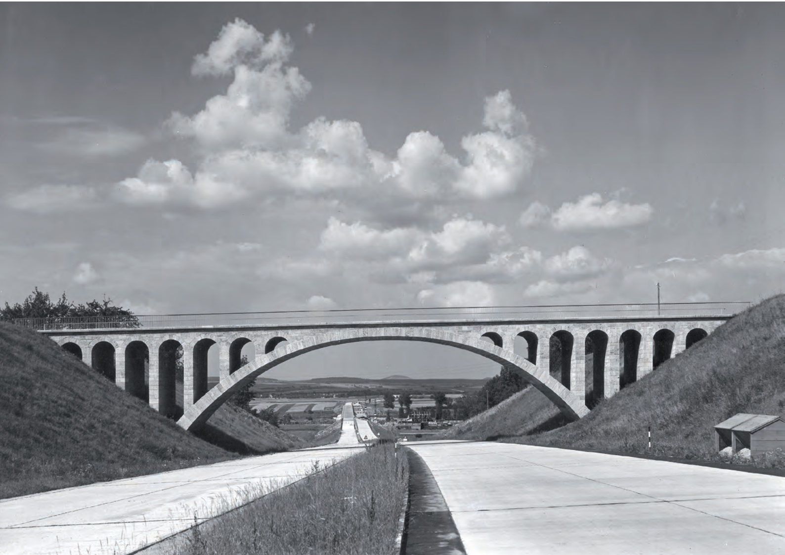
Überführung der Gemeindeverbindungsstraße Freiberg – Geisingen in km 561,445 / 1940 (Repro: 21.04.1992) Landesarchiv Baden-Württemberg StAL EL 75 VI a Nr 6076
