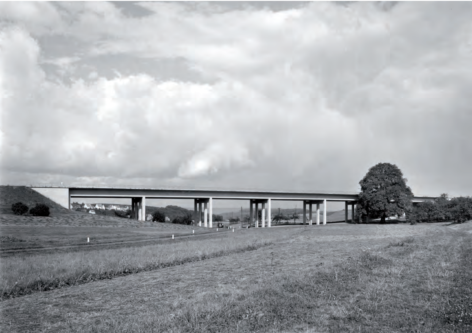
Talbrücke Denkendorf in km 186,863, Brücke fertiggestellt im September 1936 / 1936 (Repro: 04.10.1993) Landesarchiv Baden-Württemberg StAL EL 75 VI a Nr 4599
