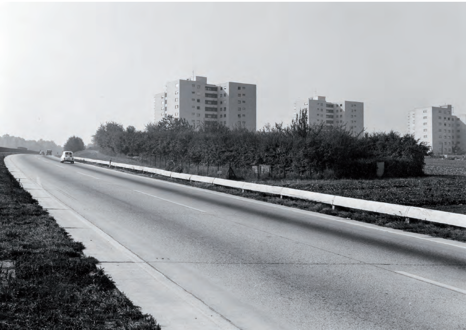
Lärmschutzwall für Hochhäuser in Asperg, km 566, Betonleitplanke / 1971 (Repro: 25.05.1992) Landesarchiv Baden-Württemberg StAL EL 75 VI a Nr 6112
