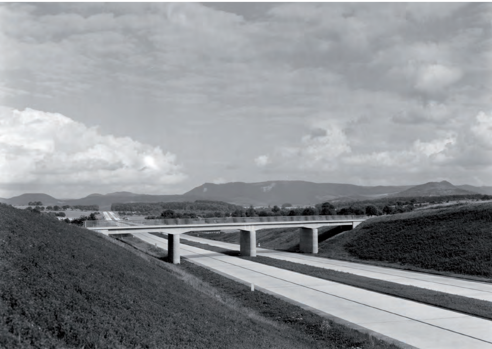
Überführung des GV Holzmaden–Weilheim in km 169,533; die Brücke wurde anlässlich des sechsspurigen Ausbaues am 04.05.1985 gesprengt und durch einen Neubau ersetzt. / 1937 (Repro: 14.12.1993) Landesarchiv Baden-Württemberg StAL EL 75 VI a Nr 4206
