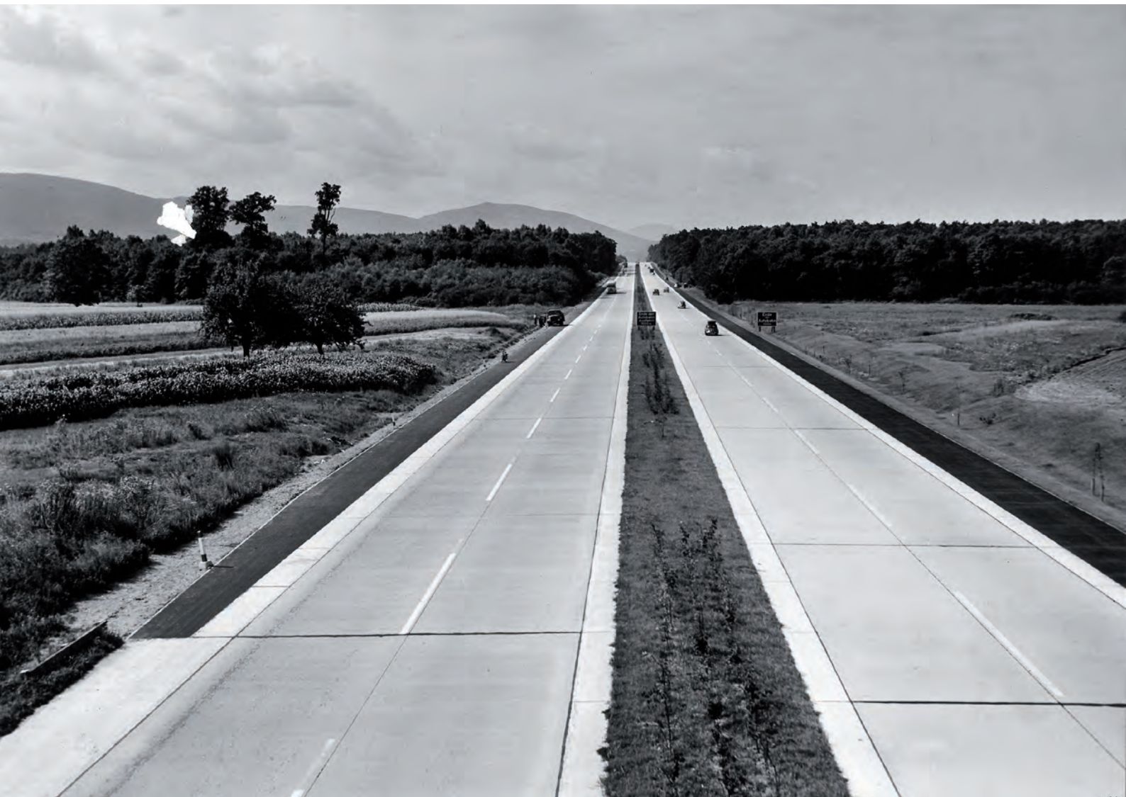
Das vorläufige Ende der A 5 der provisorischen Ausfahrt Bruchhausen bei km 636,9, Trassierung und Betonfahrbahndecke bei km 635,750, Blick in Richtung Basel / 1956 (Repro: 06.12.1991) Landesarchiv Baden-Württemberg StAL EL 75 VI a Nr 448
