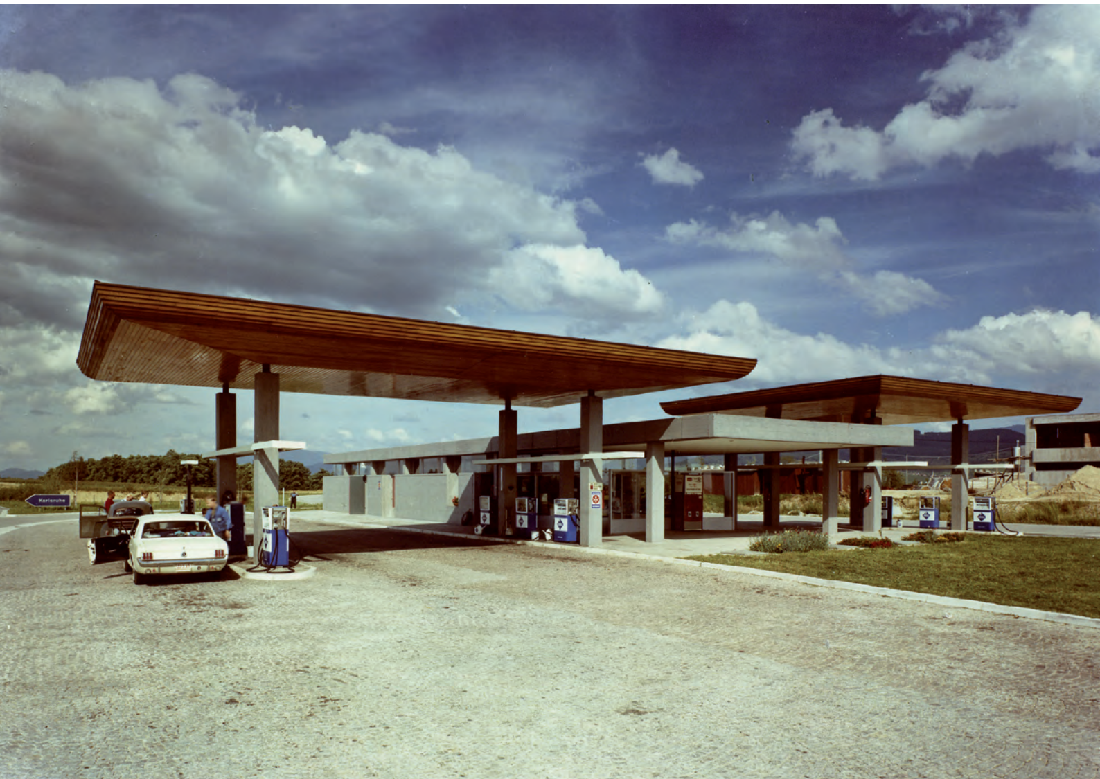
Tankstelle Breisgau, Kleinpflasterdecke, im Hintergrund Rasthaus Breisgau im Bau / 1965 (Repro: 13.03.1992) Landesarchiv Baden-Württemberg StAL EL 75 VI a Nr 1339
