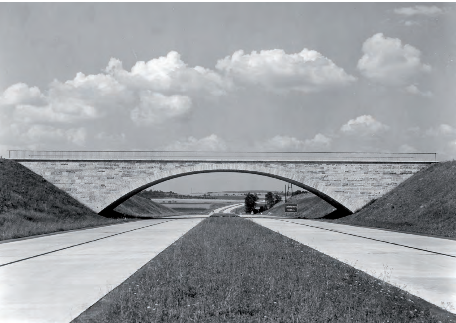
Überführung des Ortsverbindungsweges Eglosheim–Asperg (Hirschbergbrücke) in km 566,089 (neu 565,927) / 1940 (Repro: 25.05.1992) Landesarchiv Baden-Württemberg StAL EL 75 VI a Nr 6109
