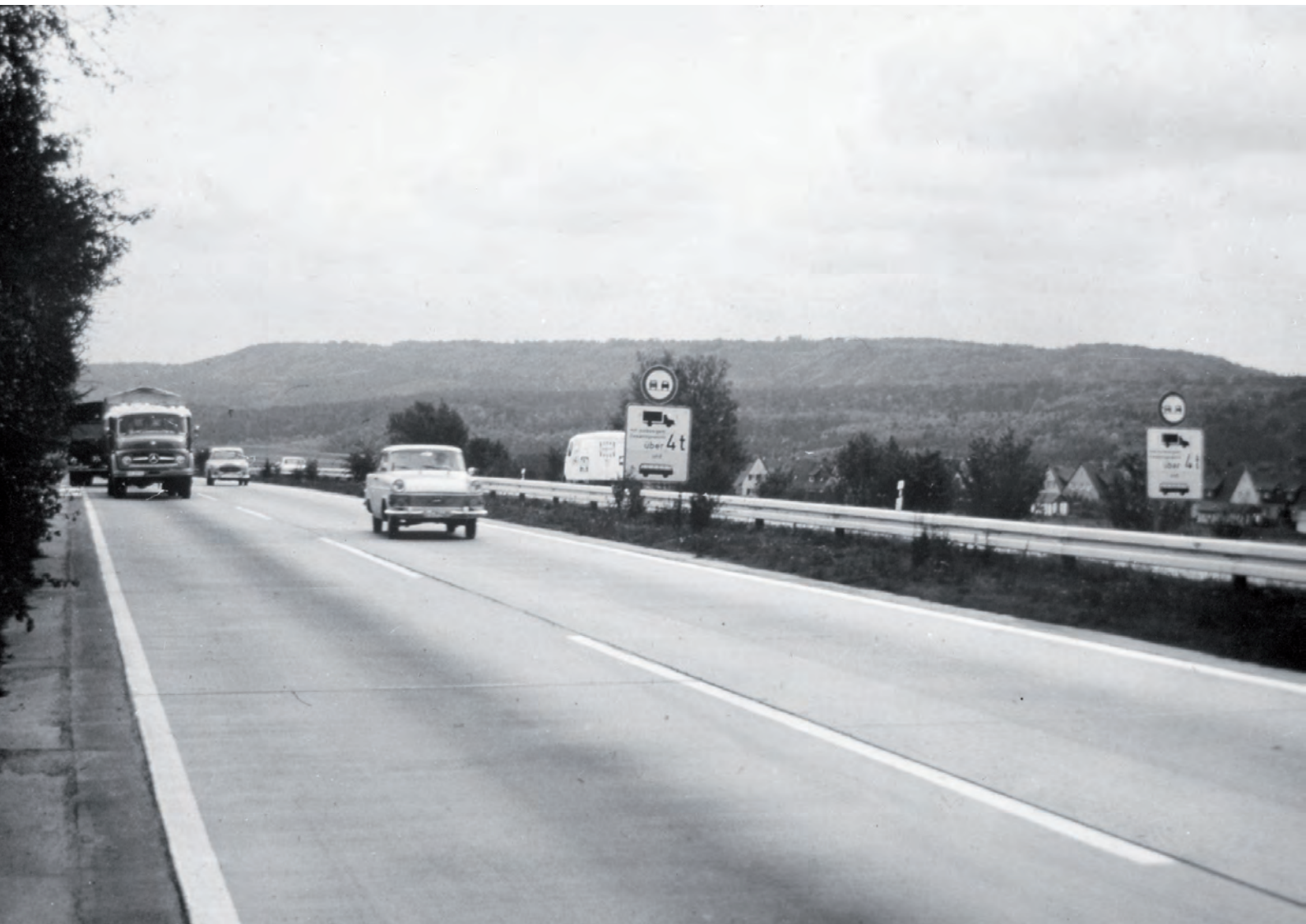
Eingebaute Fertigbetonfahrbahnplatten [AD Leonberg – AS Heimsheim] / 1959 (Repro: 05.04.1994) Landesarchiv Baden-Württemberg StAL EL 75 VI a Nr 5080
