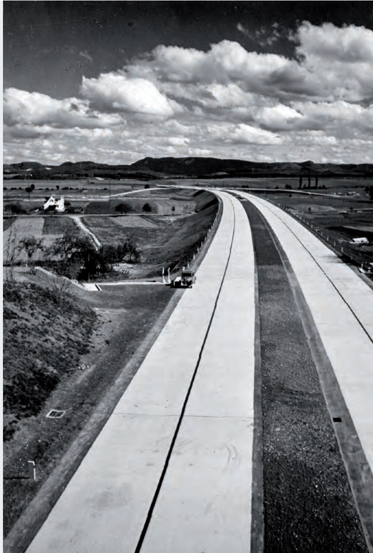
Trassierung und fertige Betonfahrbahndecke, von km 175 aus gesehen, im Hintergrund die Schwäbische Alb und AS Kirchheim-Ost / Aug. 1937 (Repro: 15.12.1993) Landesarchiv Baden-Württemberg StAL EL 75 VI a Nr 4265
