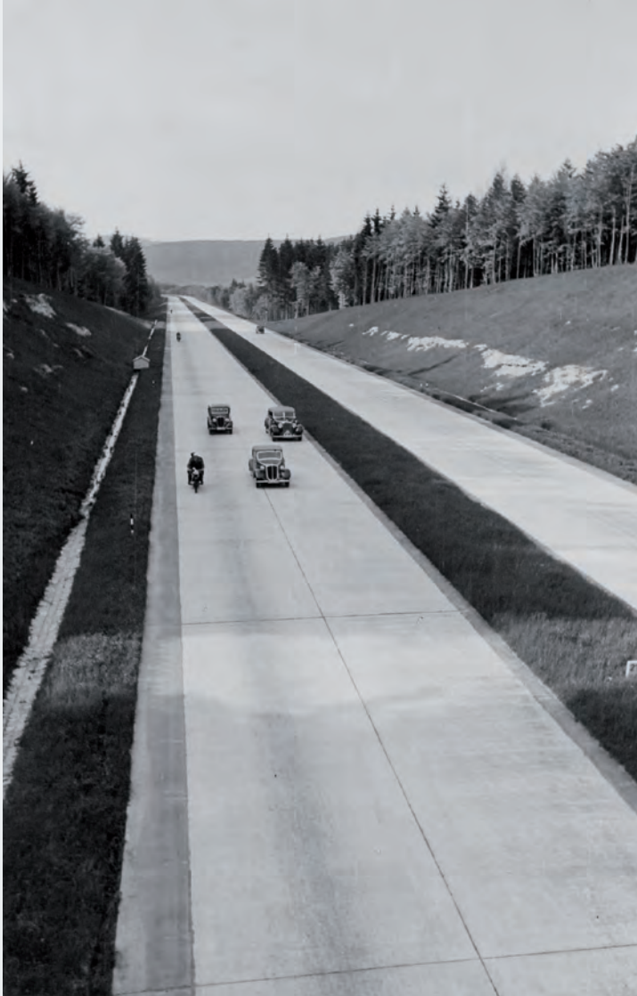
Trassierung, Muldenpflaster [AK Stuttgart – Rohrbachbrücke] / 1938 (Repro: 27.09.1993) Landesarchiv Baden-Württemberg StAL EL 75 VI a Nr 4817
