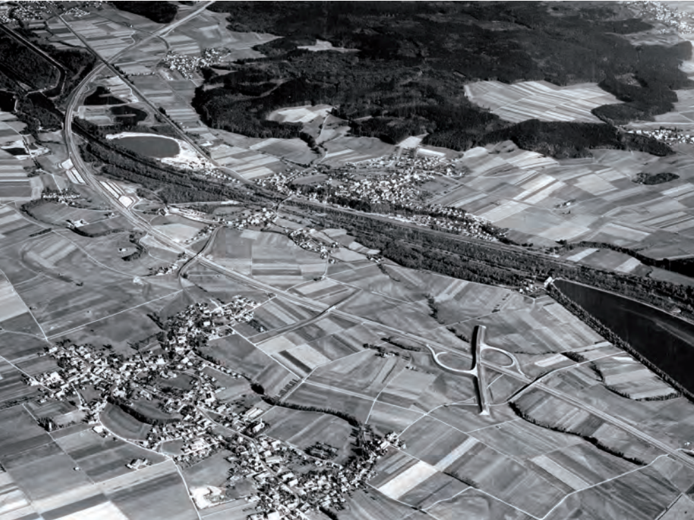
6 | Dieses Luftaufnahme der Strecke Ulm-Memmingen bei Dettlingen aus dem Jahr 1973 zeigt die sanfte Krümmung der bundesdeutschen Autobahn und die großen Übergangsbögen. (Aufnahme: Alb. Brugger, Vorlage: StAL EL 75 VIa Nr 2685)
