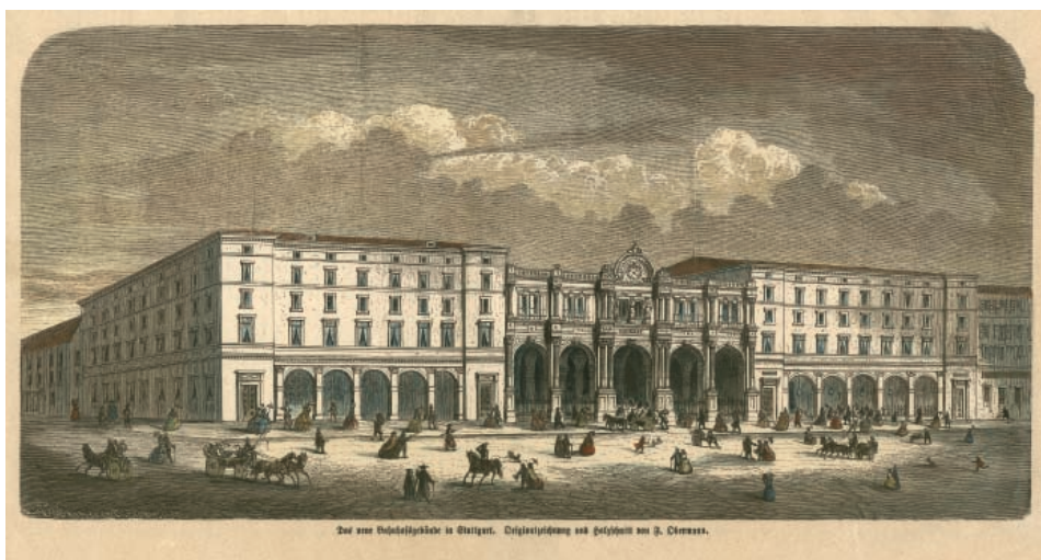
Das 1863–1867 von Georg von Morlok und Adolf Wolff erbaute neue Bahnhofsgebäude in Stuttgart, Zeichnung und Holzschnitt von F. Obermann, koloriert, 1866. Vorlage: Landesarchiv HStAS J 301 a Nr. 22
